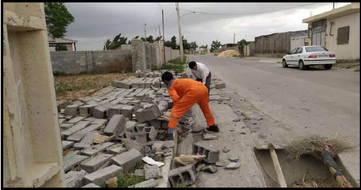
شکل (۱۳): خسارت به ابنیه و ریزش دیوار در تاریخ ۲۶ اردیبهشت ماه ۱۴۰۱
