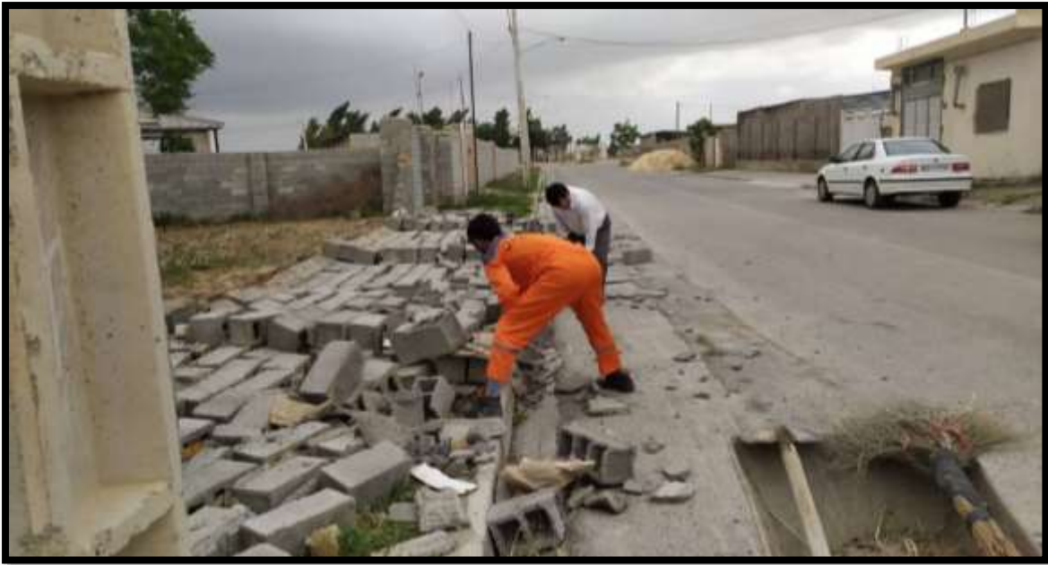
شکل شماره (۲۴) : خسارت به ابنیه و ریزش دیوار در تاریخ ۲۶ اردیبهشت ماه ۱۴۰۱
