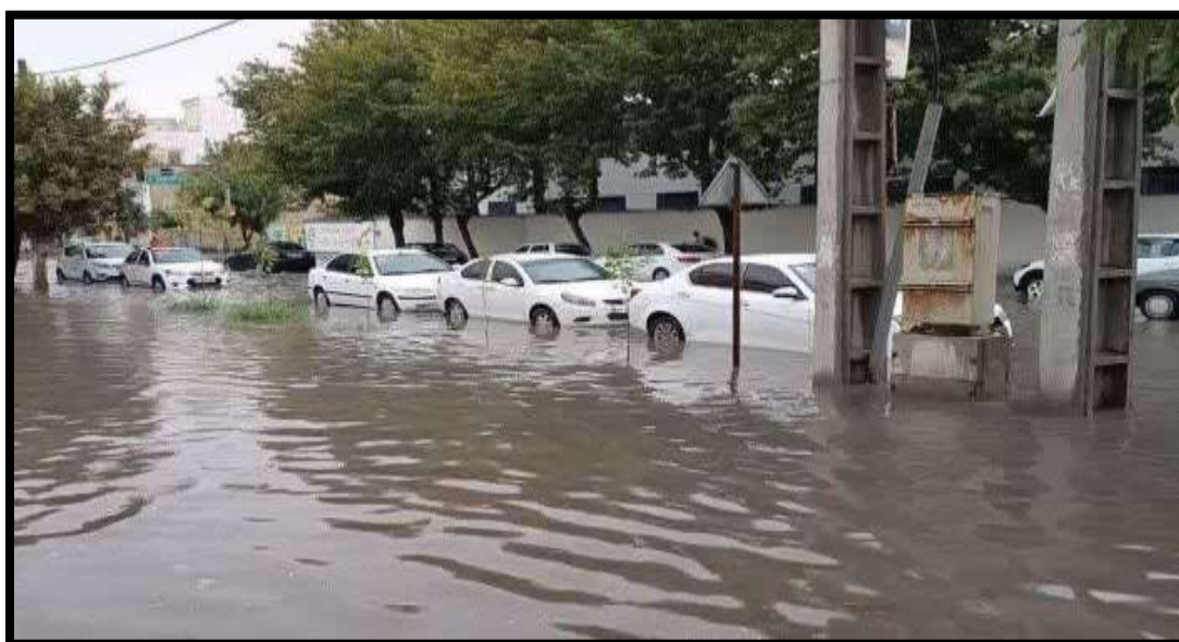
شکل شماره ۲۰: آبگرفتگی برخی از معابر شهرستان گنبد کاووس در تاریخ ۱۴۰۴/۶/۲۹
